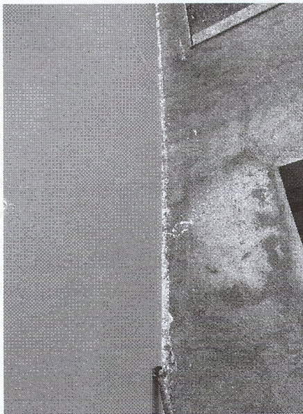
=> TRATAMENTO DE JUNTA DE DILATAÇÃO NA FACHADA POSTERIOR - DETALHE - COR BRANCA
