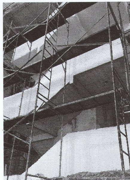
=> PINTURA EM PAREDE INTERNA - DETALHE
