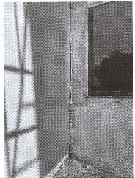
=> TRATAMENTO DE JUNTA DE DILATAÇÃO NA FACHADA FRONTAL - DETALHE - COR CINZA
