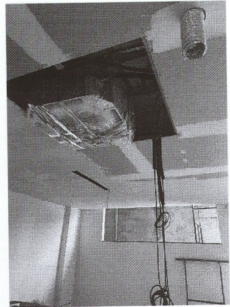
=> SISTEMA DE AR CONDICIONADO - EQUIPAMENTO TIPO CASSETE
