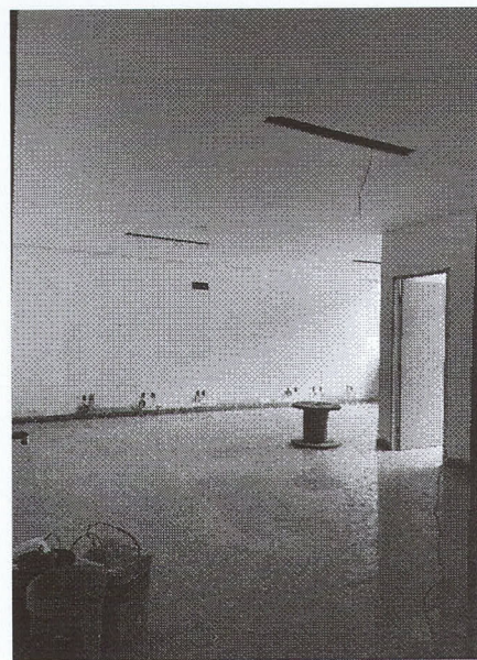
=> FORRO, EMASSAMENTO, RODAPÉ, PORTA - 1 PAVIMENTO
