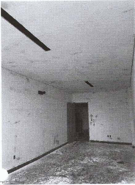
=> FORRO EM DRYWALL - 1 PAVIMENTO
