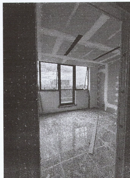
=> Paredes e Acabamento - 3 Pavimento
