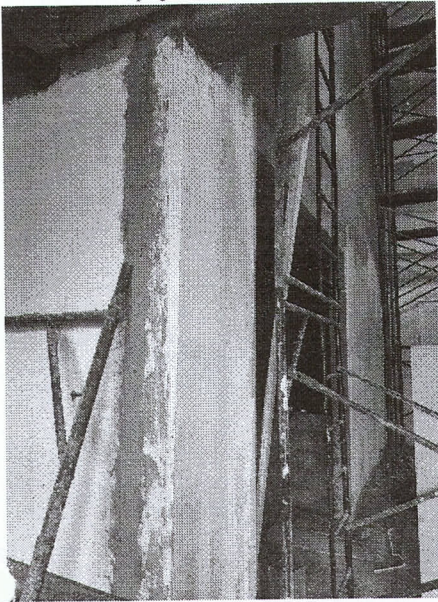
=> Tratamento de Juntas de Dilatação
