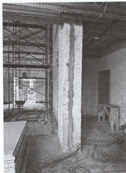
=> Tratamento de Juntas de Dilatação
