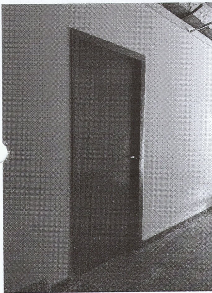
=> Pintura de Esquadria - 1 Pavimento
