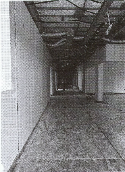
=> Circulação - Pintura - 2 Pavimento
