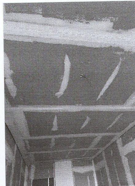
=> Forro em drywall e acabamentos - 3 Pavimento
