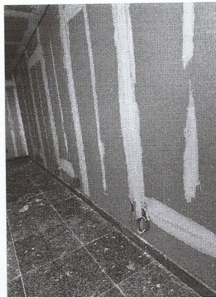
=> Vedação e Instalações - 3 Pavimento
